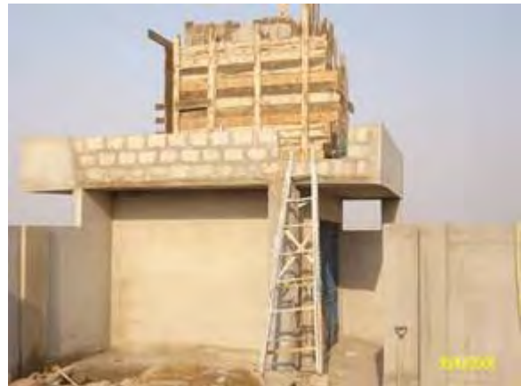
Der neue Wassertank entsteht
