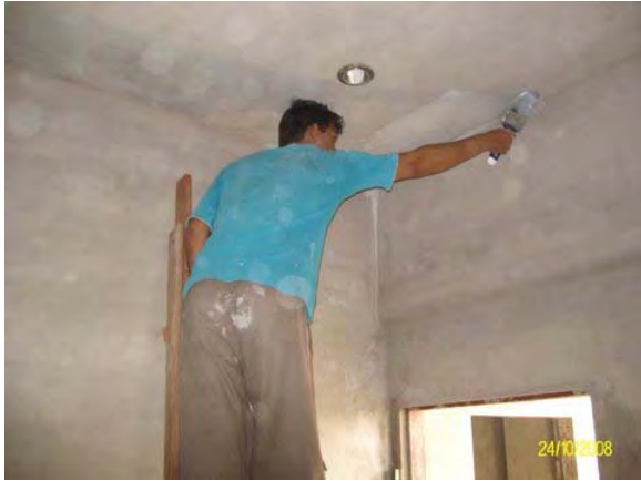
Verputz der neuen Klassenzimmer
