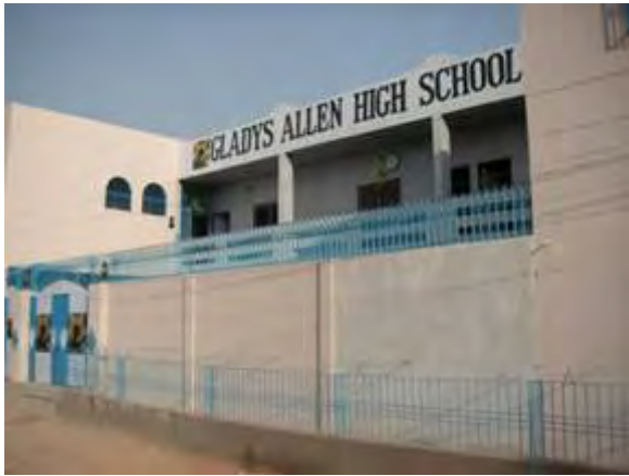
Die GAHS vor dem Ausbau...
