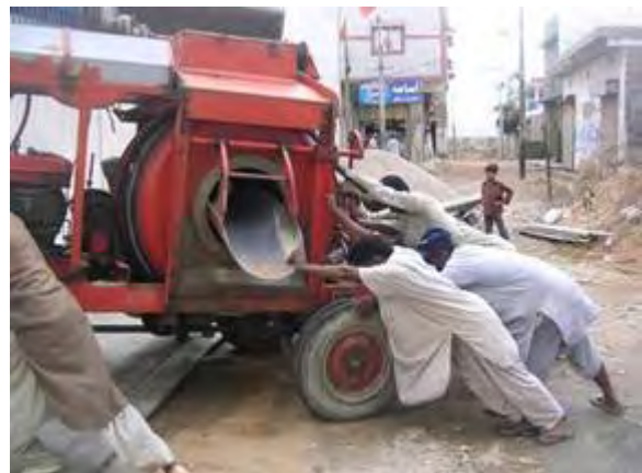
Der Betonmischer wird für einen Tag gemietet
