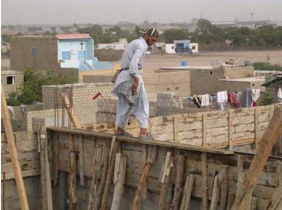
Verschaltungsarbeiten
