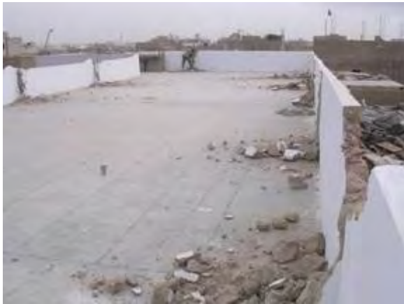
Vorbereitungsarbeiten auf dem Dach
