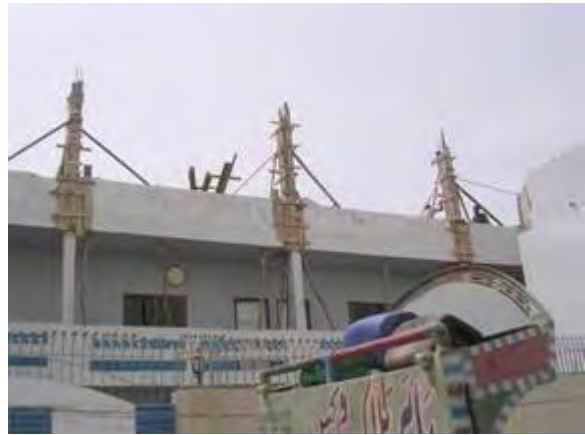
Neue Stützpfiler werden errichtet
