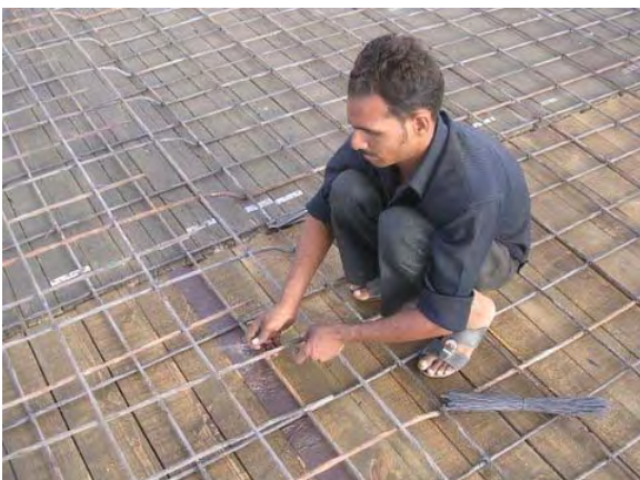
Armierungseisen verlegen
