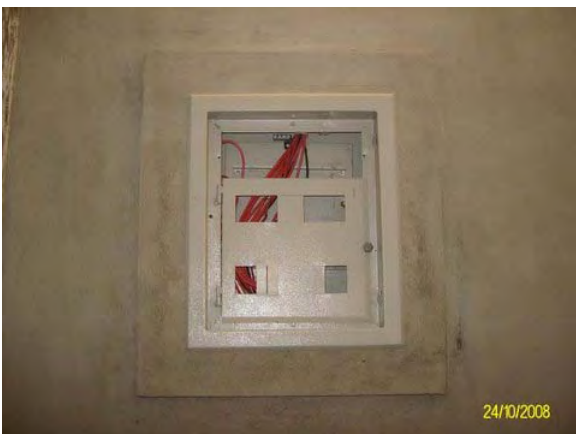
Komplette Erneuerung der elektrischen Installationen
