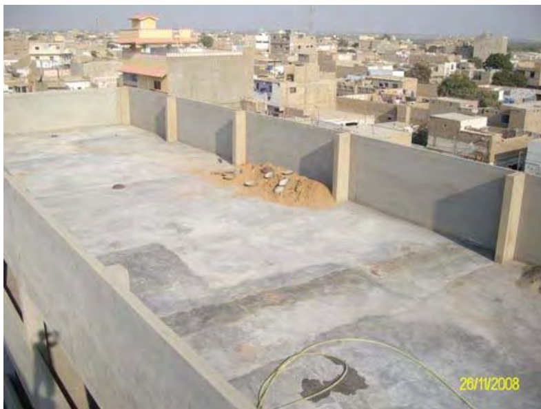
Blick vom Wassertank auf das neue Schuldach
