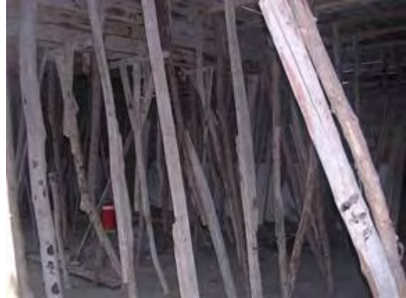
Abstützung des neu entstehenden Stockwerks
