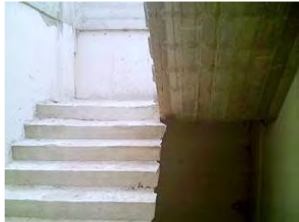
Das Treppenhaus zum neuen Stockwerk
